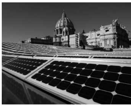
Il fotovoltaico sulla copertura di Sala Nervi.
